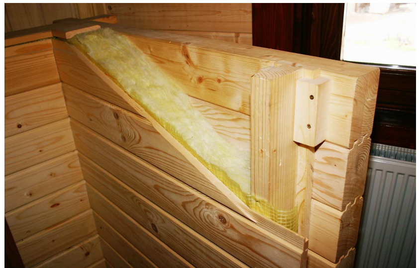
TOIT : Laine de Roche Ep 200 mm MURS : Laine de Roche Ep 140 mm
